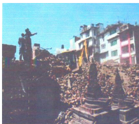
Figura 11. Daños de estructuras por el terremoto.
