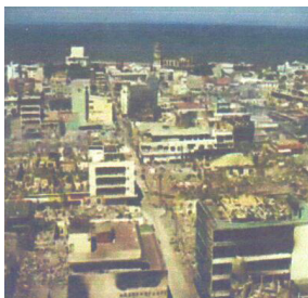
Figura 12. Daños de estructuras por el terremoto.
